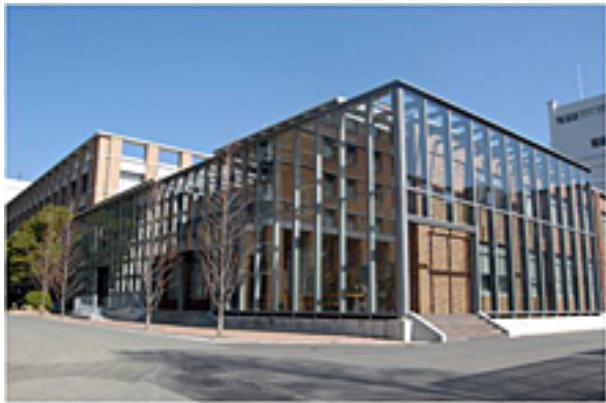
改修後の工学研究科本館
