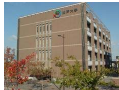
(神戸ポートアイランド地区)
